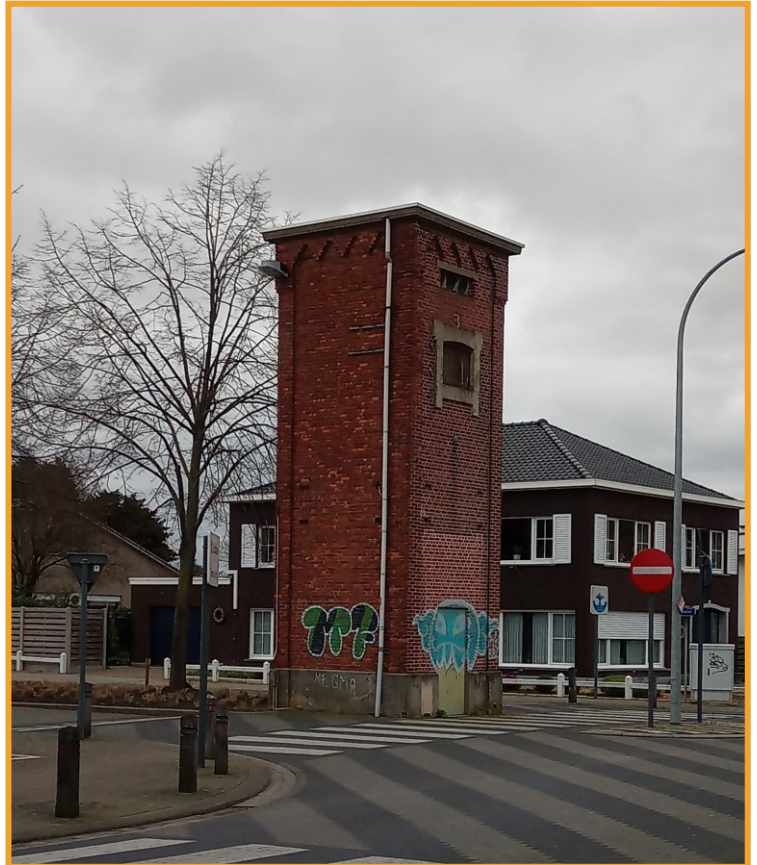
Elektriciteitskabine of transformatorhuisje © All-Archeo
